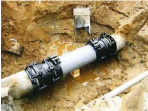
漏水防止のための整備
