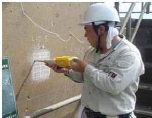
老朽化した施設の機能診断
