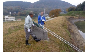
ため池の現地パトロール
