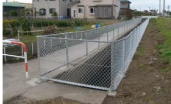
安全施設の整備
