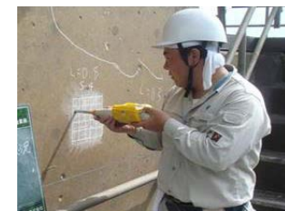
老朽化した施設の機能診断
