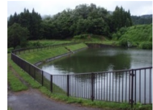
転落防止柵の整備
