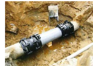
漏水防止のための整備
