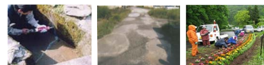
水路のひび割れ補修 農道の窪みの補修 植栽活動
