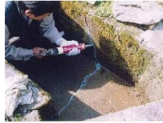
水路のひび割れ補修
