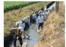
水路の泥上げ
