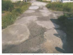
農道の窪みの補修
