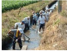
水路の泥上げ
