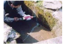
水路のひび割れ補修
