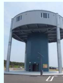
津波避難タワー
