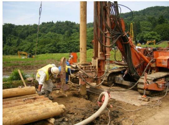
整備効果を一層促進させるため、洗浄用水の供給施設等の関連整備等を一体的に実施
