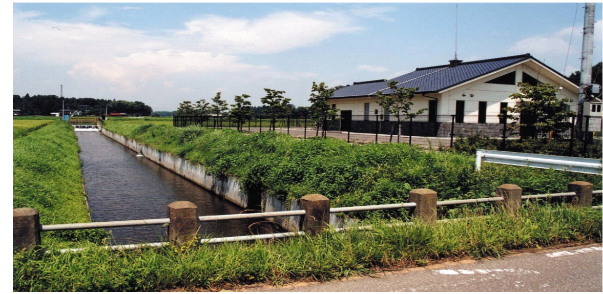
【農業集落排水施設】
