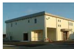
集出荷貯蔵施設
