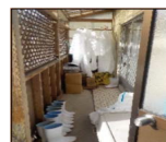
離乳豚舎前室の整備
