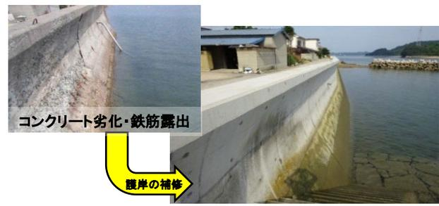
コンクリート劣化・鉄筋露出
