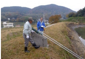
ため池の現地パトロール
