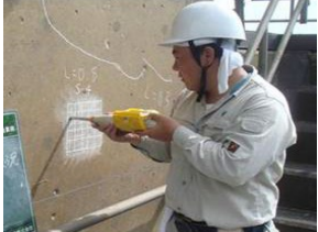
老朽化した施設の機能診断
