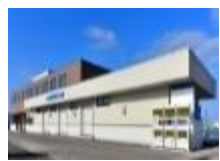
集出荷・貯蔵・加工施設の整備
