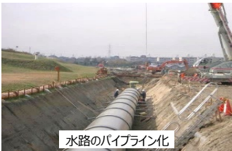
水路のパイプライン化
