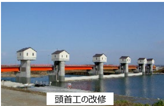
頭首工の改修
