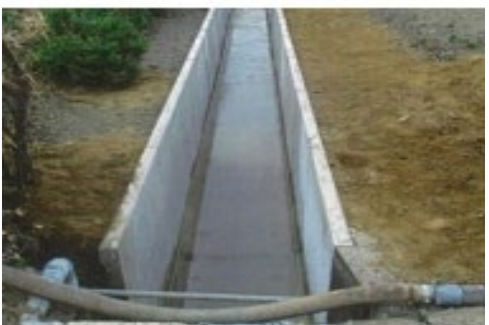
排水路の補修・更新等
