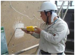
老朽化した施設の機能診断
