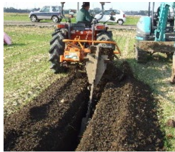
暗渠排水の整備
