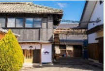
遊休施設を活用した滞在施設の整備
