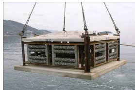
魚礁の新設・移設
