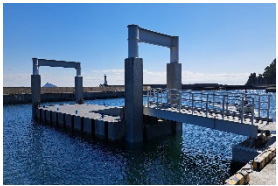
浮体式係船岸の整備
