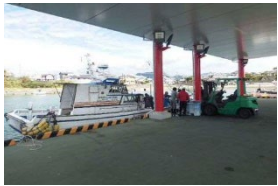
岸壁の屋根の整備
