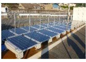
太陽光パネルの設置
