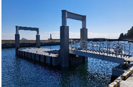
浮体式係船岸の整備
