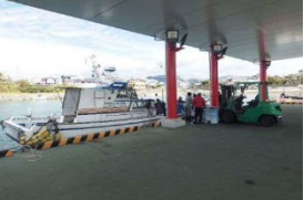
岸壁の屋根の整備
