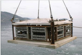
魚礁の新設・移設
