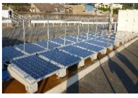
太陽光パネルの設置
