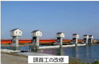
頭首工の改修
