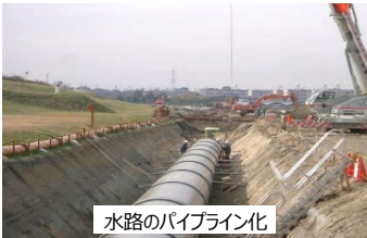
水路のパイプライン化
