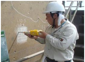
老朽化した施設の機能診断
