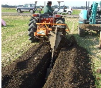
暗渠排水の整備
