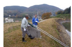
ため池の現地パトロール
