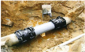
漏水防止のための整備
