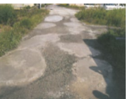
農道の窪みの補修
