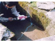
水路のひび割れ補修
