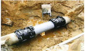
漏水防止のための整備
