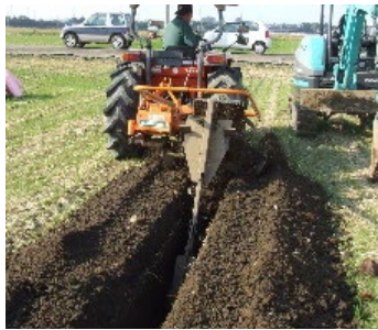
暗渠排水の整備
