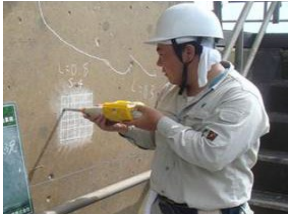
老朽化した施設の機能診断
