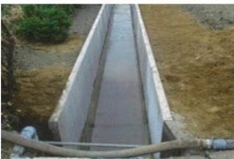
排水路の補修・更新等
