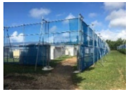
防風ネットの設置
