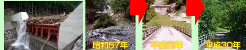
治山ダム工等の施設の設置により、溪岸・溪床の侵食防止や山脚の固定等を図り、森林の生育基盤を確保します。また、流木を捕捉する治山ダム工の設置も推進しています。
