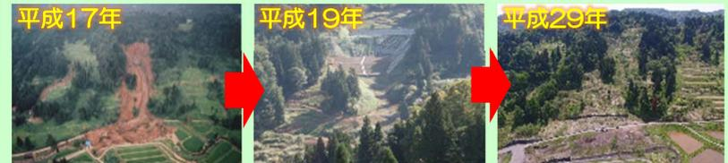
地すべりが発生する要因を除去する抑制工と、直接的に地すべり土塊の動きを止める抑止工を組み合わせ、地すべりを防止します。
