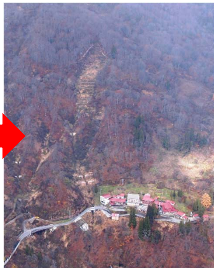
平成28年 復旧状況
