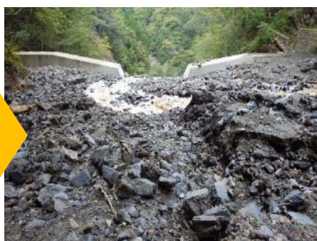
【土石流の流下エネルギーを治山ダムが軽減】
