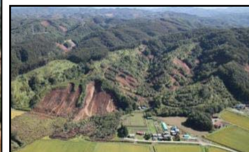
山腹崩壊状況
