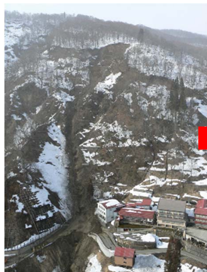
平成17年 被災状況
