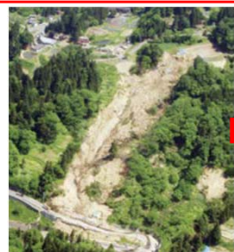
平成17年 被災状況
