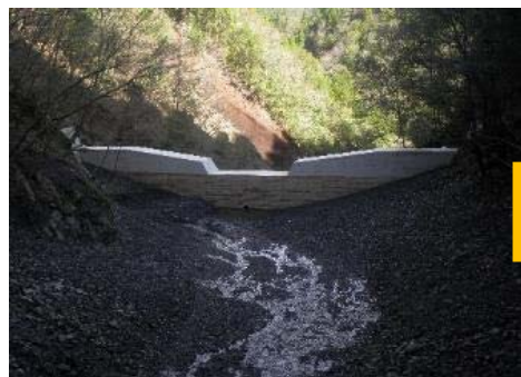
【土石流の流下防止のための治山ダムの設置】 (高知県馬路村)
