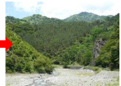
平成22年 復旧状況
