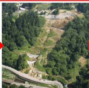
平成18年 施工後 ＜新潟県小千谷市＞
