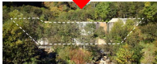
施工後30年経過状況
