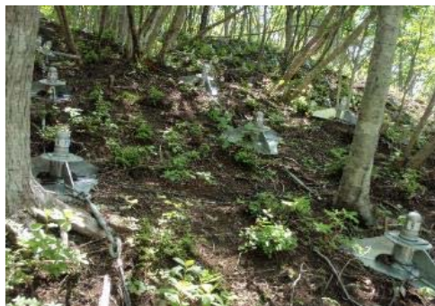
【ノンフレーム工法による斜面崩壊の防止】 (宮城県栗原市)
