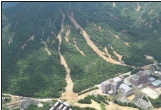
山腹崩壊状況
