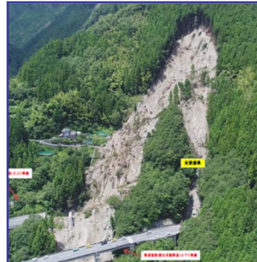
山腹崩壊状況
