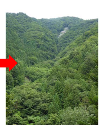
平成29年 復旧状況
