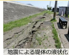
地震による堤体の液状化
