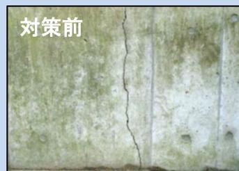
護岸に亀裂。将来的に護岸の機能低下が生じるおそれ。
