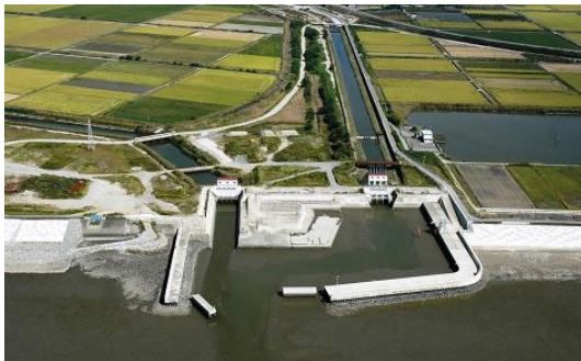
排水樋門の改修
