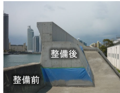
海岸堤防の嵩上げ
