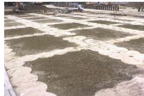
地盤改良の施工後
