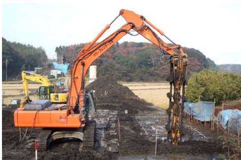
地盤改良の施工中
