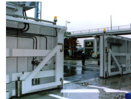
陸閘の自動化・遠隔化
