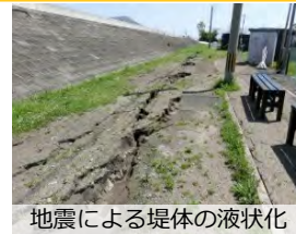
地震による堤体の液状化
