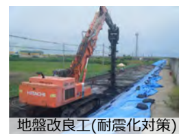
地盤改良工（耐震化対策）
