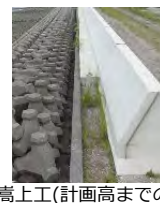
堤防高上工（計画高までの整備）
