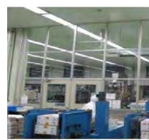
空気を経由した汚染を防止する設備（パーティション）の導入
