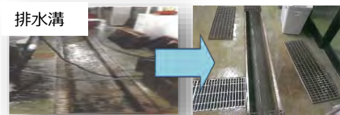
施設の衛生管理の強化に対応する排水溝、床、壁等の改修
