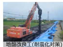
地盤改良工（耐震化対策）
