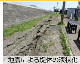
地震による堤体の液状化
