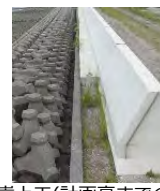
堤防高上工（計画高までの整備）
