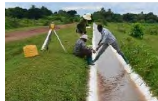
施工後の改善効果の検証状況
