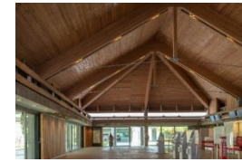
空港(沖縄県宮古島市)
