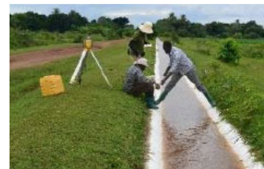
施工後の改善効果の検証状況
