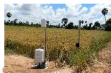
ICT水管理システムの導入
