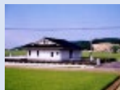
農業集落排水施設
