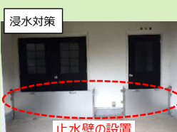
止水壁の設置
