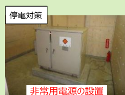
非常用電源の設置
