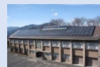
地域資源利活用施設 (太陽光発電施設)
