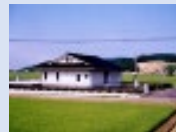
農業集落排水施設
