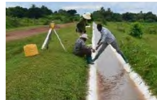
施工後の改善効果の検証状況
