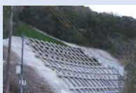
集落防災安全施設 (土砂崩壊防止施設)
