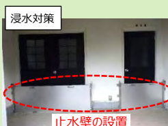
止水壁の設置
