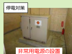
非常用電源の設置
