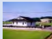
農業集落排水施設
