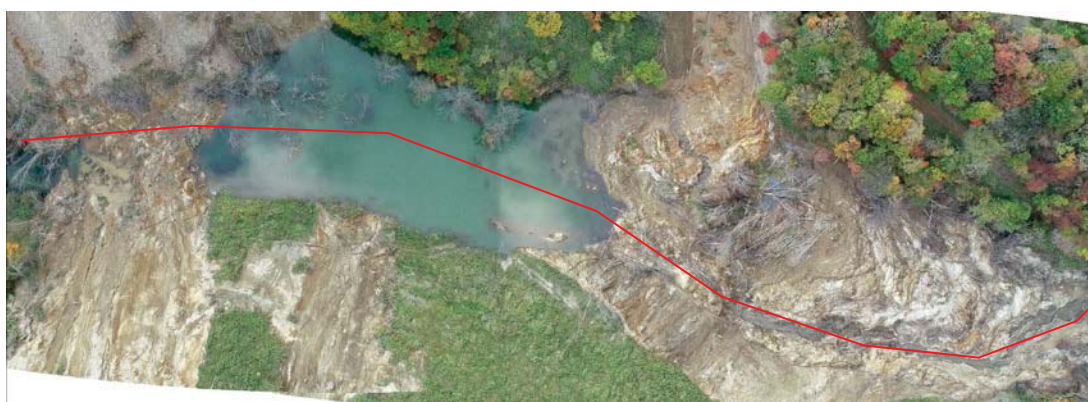
写真 2-18 地震により発生した大規模被災地の状況
