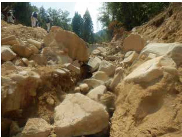
溪床洗掘とコアストーン
