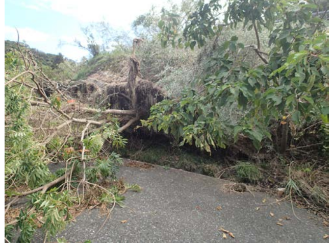
（↑道路沿いの広葉樹の根返り）
