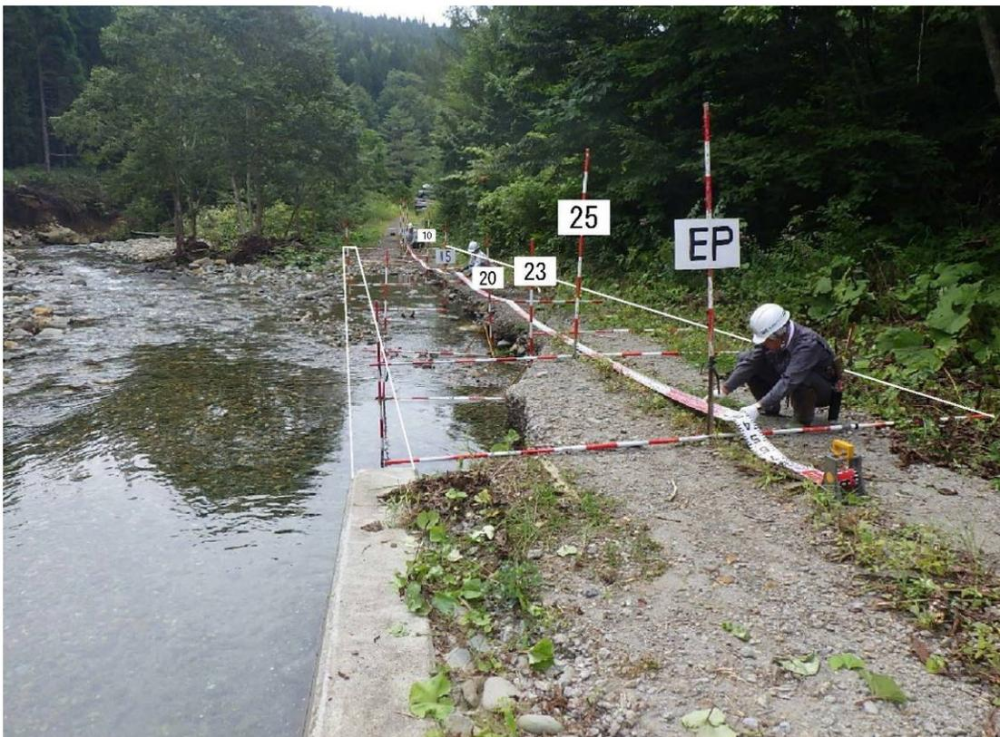
写真 2-6 平成 29 年災害 秋田県 溪流の洪水流による侵食
