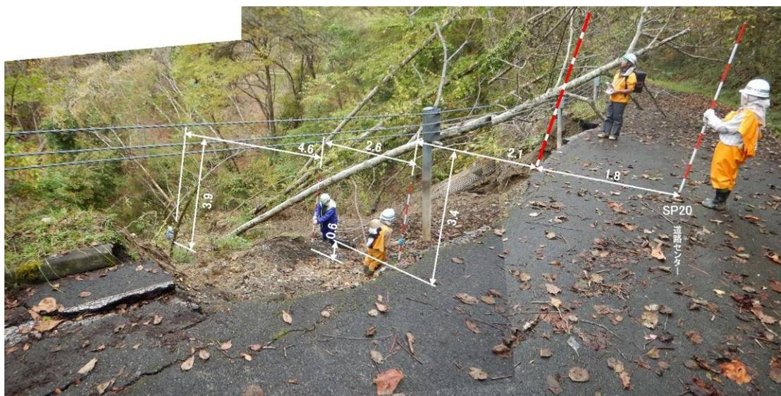
写真 2-4 平成 30 年災害 北海道 盛土部への浸透水の飽和による路肩・路体決壊
