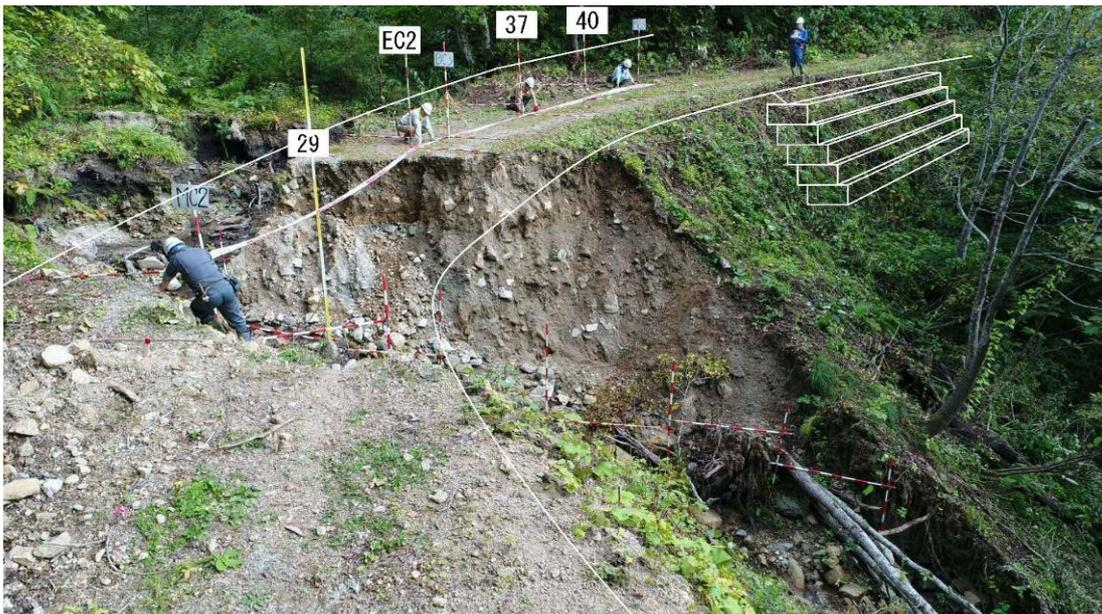
写真 2-5 平成 29 年災害 秋田県 溪流横断部暗きよの閉塞による流下水の越流
