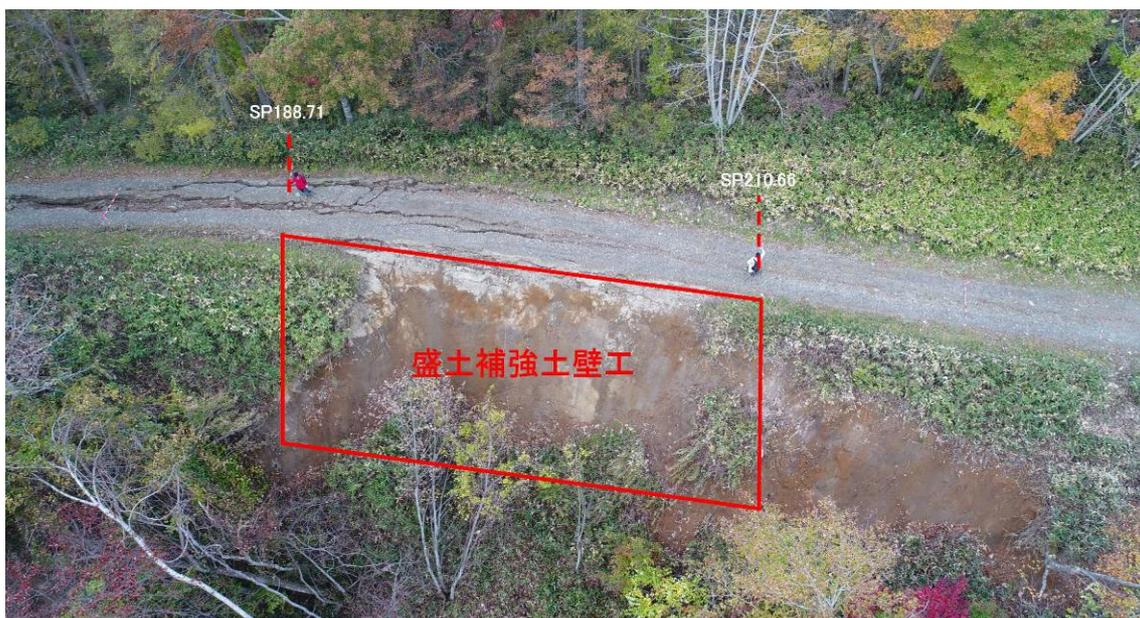
写真 2-3 平成 30 年災害 北海道 路面水の集中流下による路肩・路体決壊
