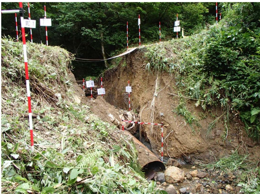
写真 2-8 平成 29 年災害 新潟県 排水施設の閉塞等に起因する路体崩壊
