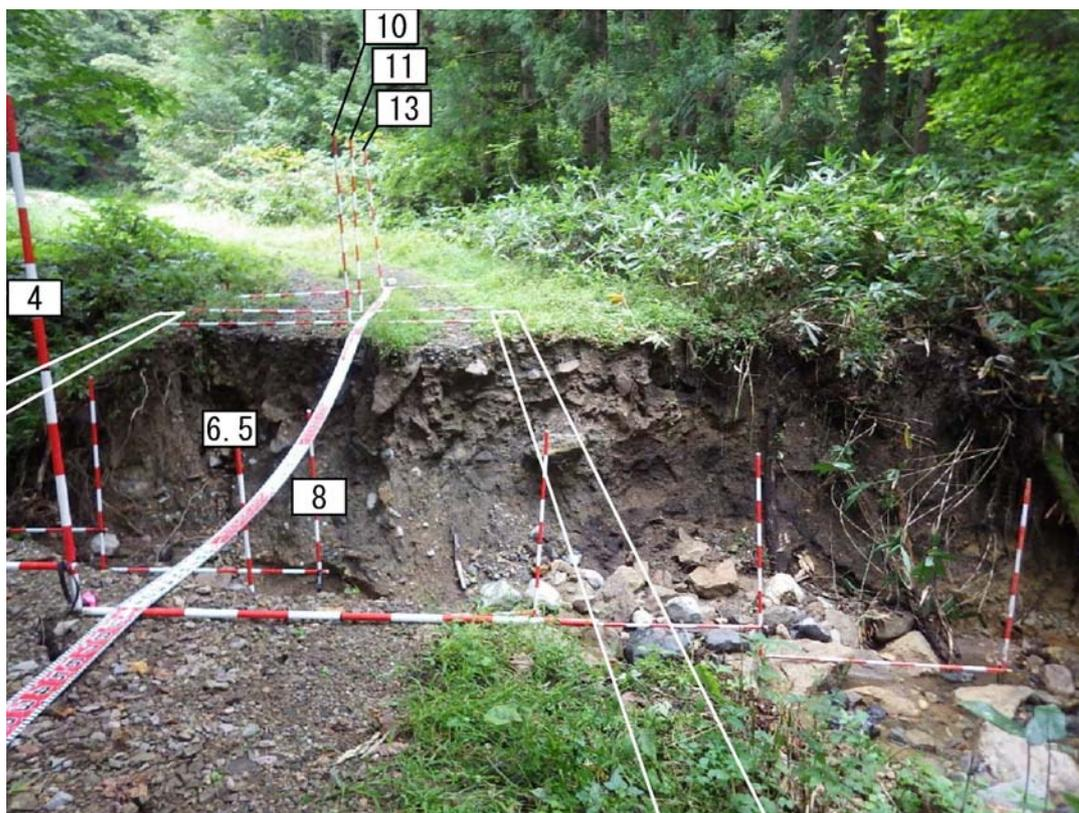
写真 2-7 平成 30 年災害 秋田県 溪流横断部暗きよの閉塞による流下水の越流
