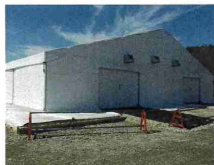
増設された既舎
