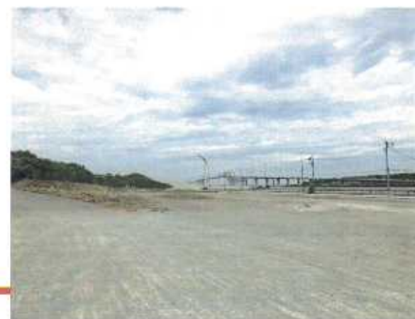
舗装エリア(厩舎予定箇所)
