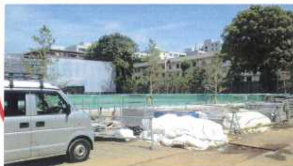
南エリア(厩舎周り建設中)
