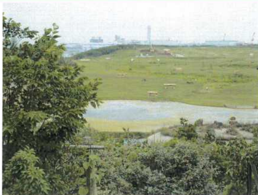
コース上の障害物と工事(スタートエリア付近)
