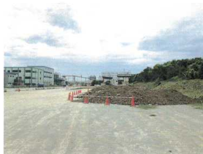
舗装エリアの工事(盛土)
