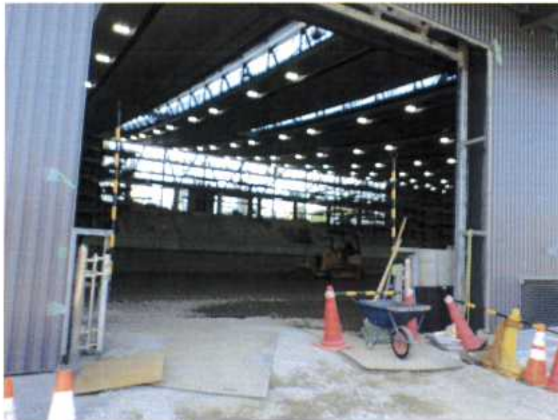
アリーナ(内部工事中)
