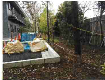
検疫厩舎周り
