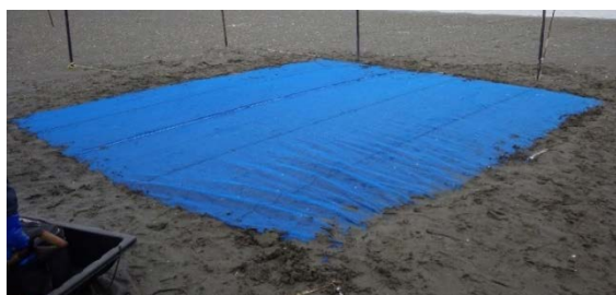
写真 1. 縁辺部埋設 (ショベルを使用して埋設)
