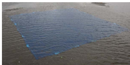
写真 2. 沈子ロープ+杭固定 (青色のハトメ部位からロープを出して杭固定)
