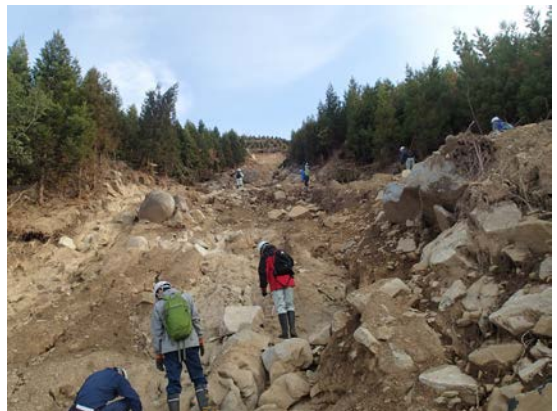
（崩壊源頭部付近）
