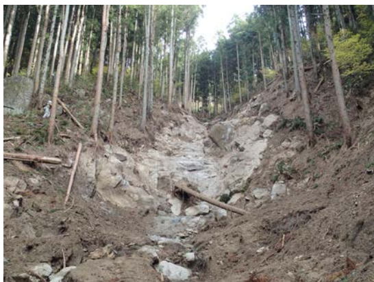
(崩壊源頭部付近)
