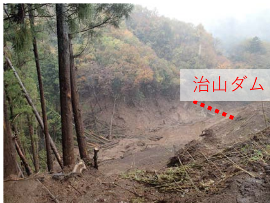
(市道より下部の土砂流出状況)
