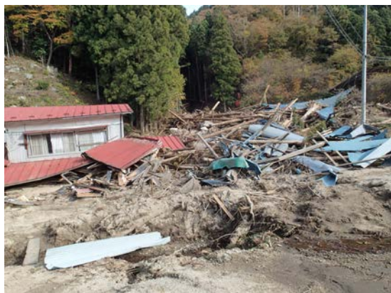
(土石等の流出に伴う人家被害)
