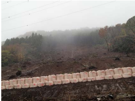
(市道より上部全景)
