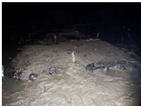
図7 平成31年1月の泥の堆積状況
